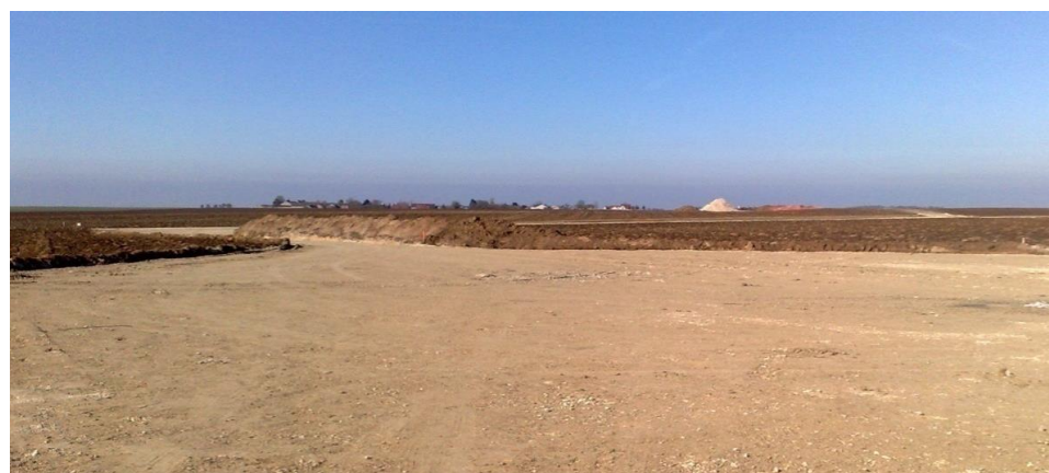
Figure 138 : Exemple d'aire de montage, grave compactée sur géotextile
