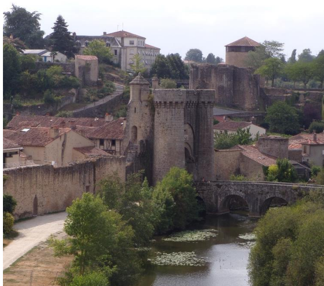
Figure 127 : Château de Parthenay (© ATER Environnement, 2018)
